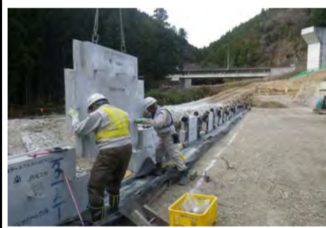
補強土壁 施工状況
