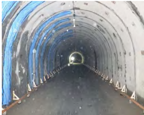
型枠設置完了
