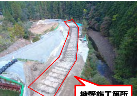
擁壁施工箇所 (地盤改良の上に擁壁を作ります。)
