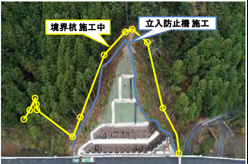
本線(立入防止柵・境界杭 施工中)
