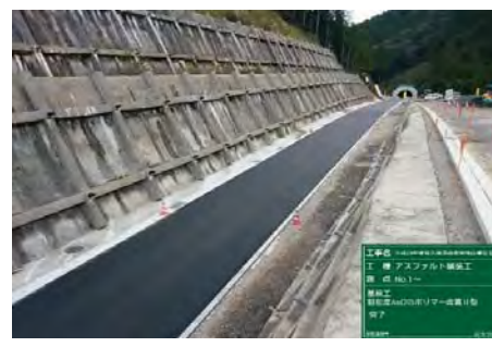
ランプ舗装 基層完了
