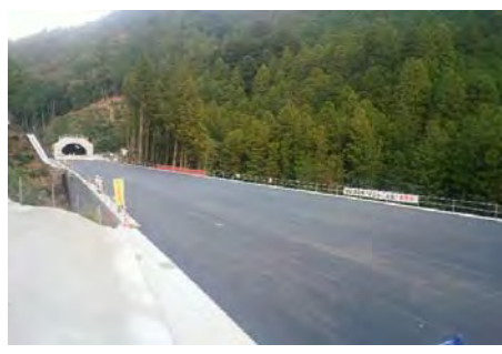
本線舗装 基層完了
