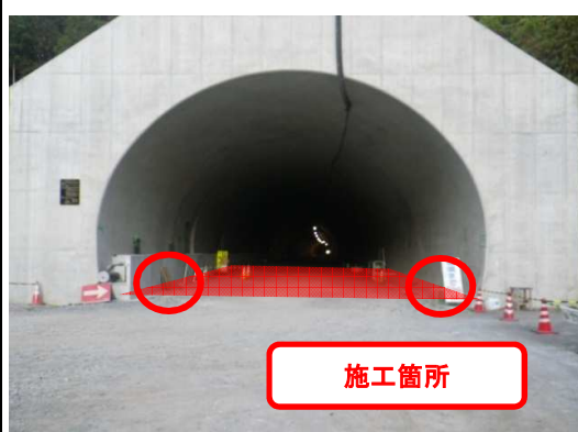
トンネル本坑口(東栄側)
