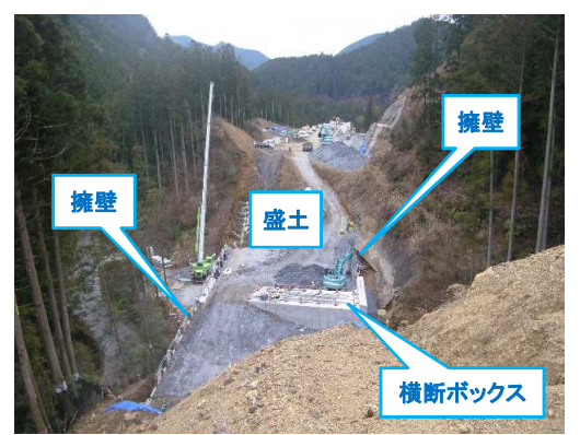
本線 横断ボックス及び擁壁
