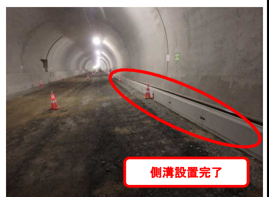
トンネル内状況(側溝設置)
