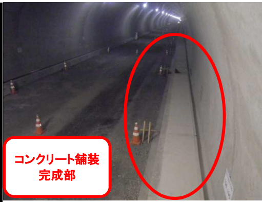
トンネル内状況
