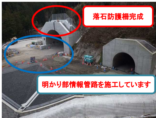
トンネル本坑口(東栄側)
