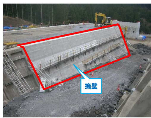
ランプ部 擁壁
