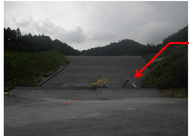
盛土施工箇所
