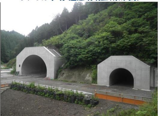
トンネル本坑・避難坑坑口(東栄側)
