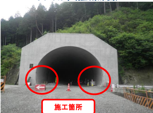
トンネル本坑口(東栄側)
