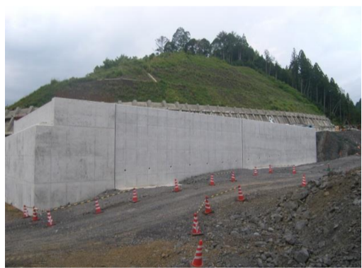
現場打ち逆T型擁壁(本線)
