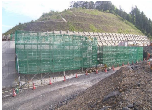
現場打ち逆T型擁壁(本線)
