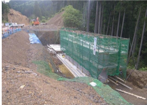
現場打ちL型擁壁(本線OFFランプ)
