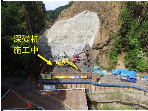
橋台施工箇所
