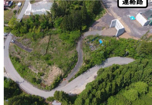
本線右(ONランプ)側
