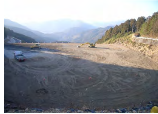
横見地区施工箇所
