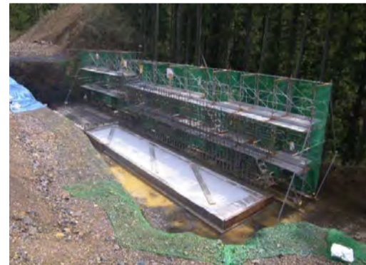
現場打ちL型擁壁(本線OFFランプ)
