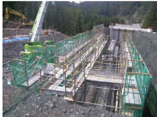
現場打ち逆T型擁壁(本線)
