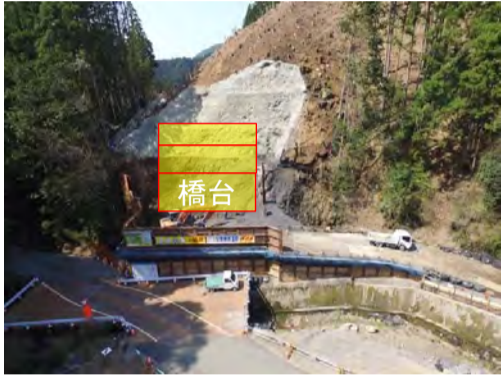
橋台施工箇所
