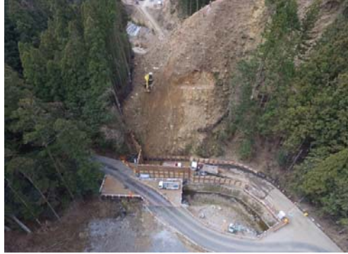
橋台施工箇所
