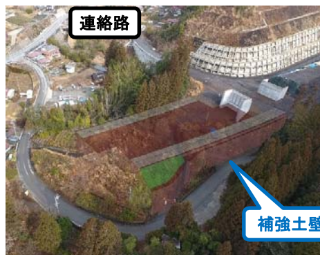
本線右(ONランプ)側
