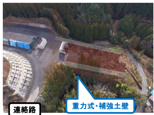
本線左(OFFランプ)側
