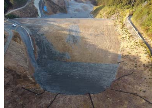
横見地区施工箇所
