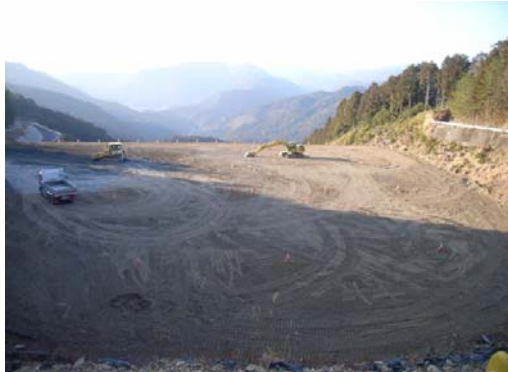
横見地区施工箇所
