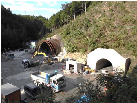
トンネル坑口状況
