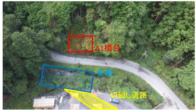
橋台施工箇所
