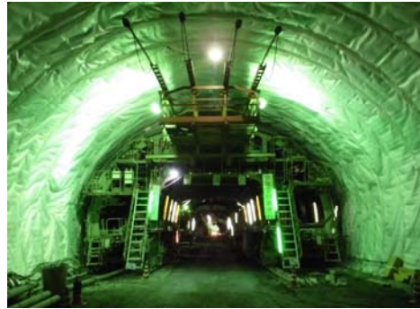
本坑施工状況
