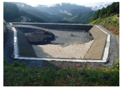
横見地区施工箇所
