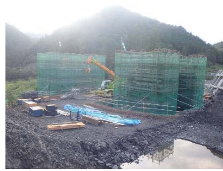
東栄IC(仮称)施工箇所
