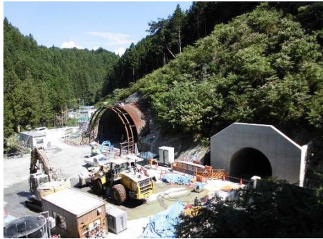
トンネル坑口状況
