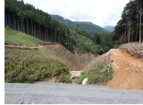
横見地区施工箇所
