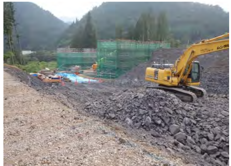
東栄IC施工箇所
