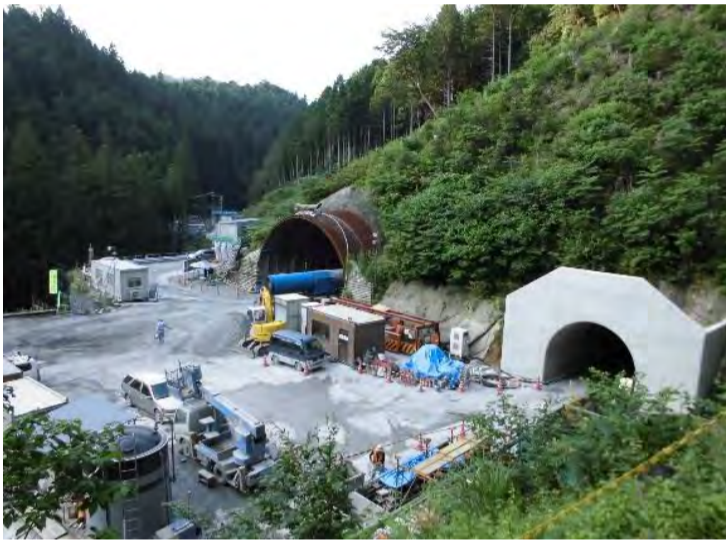
水平ボーリング実施状況
