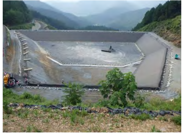
横見地区施工箇所
