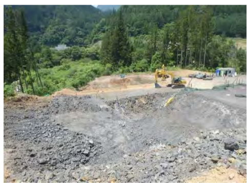
東栄IC施工箇所
