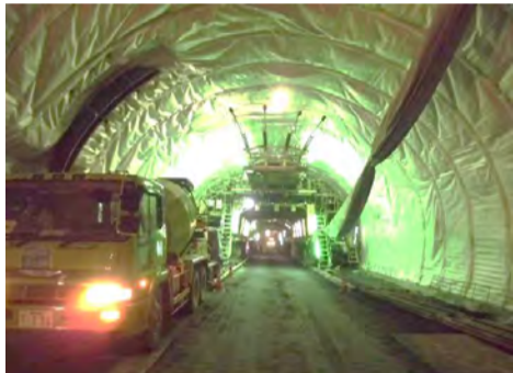
本坑 覆工コンクリート状況
