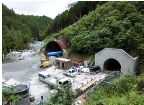
トンネル坑口状況
