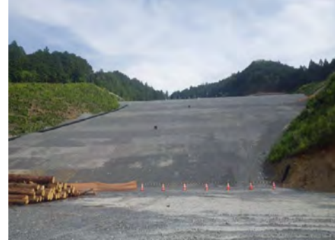
横見地区施工箇所
