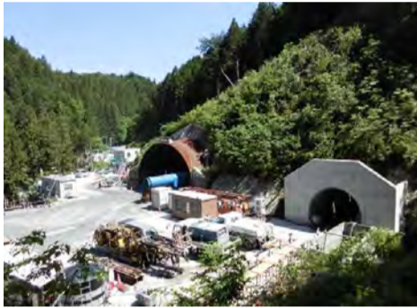
トンネル坑口状況
