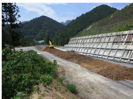
東栄IC施工箇所
