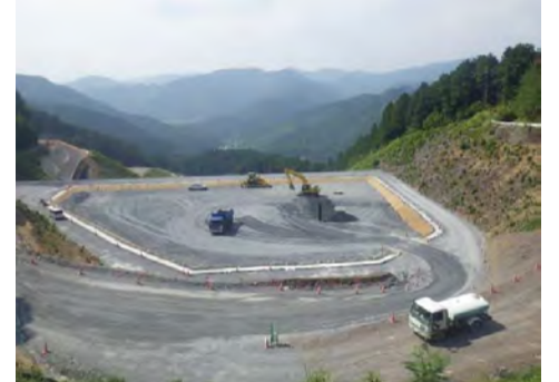
横見地区施工箇所
