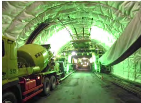
本坑 覆工コンクリート状況
