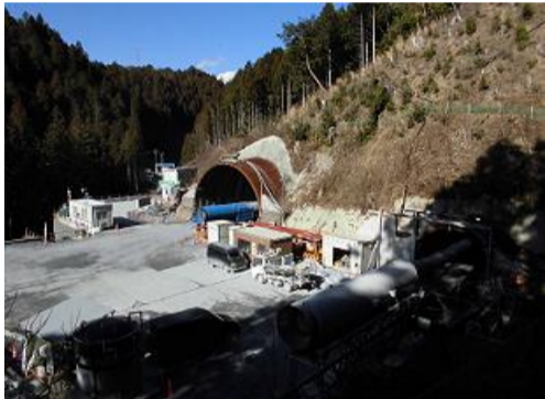
トンネル坑口状況
