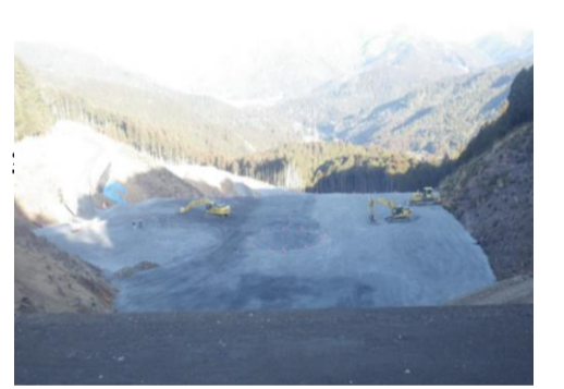
横見地区施工箇所
