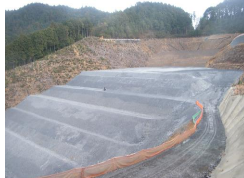
横見地区施工箇所
