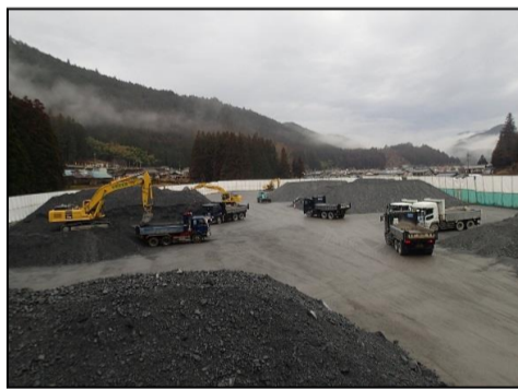
ハツ田仮置場 施工状況
