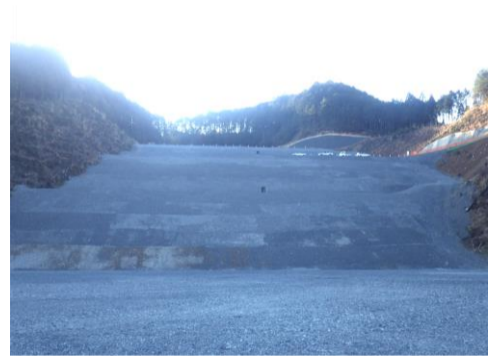
横見地区施工箇所
