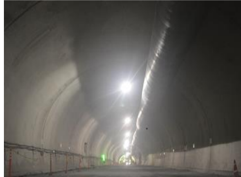
本坑施工状況(覆工コンクリート状況)
