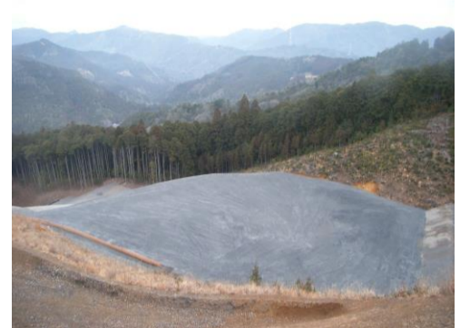
横見地区施工箇所
