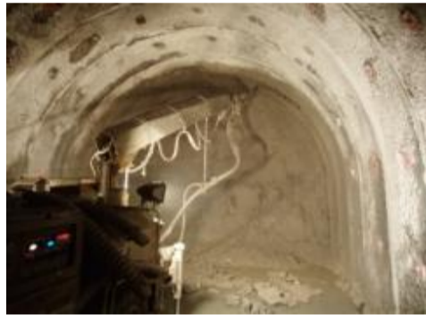
避難坑施工状況(コンクリート吹付け)
