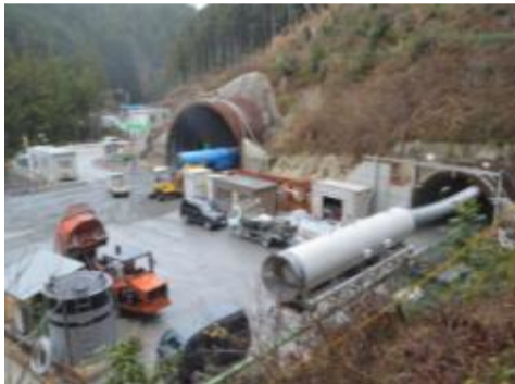
トンネル坑口状況
