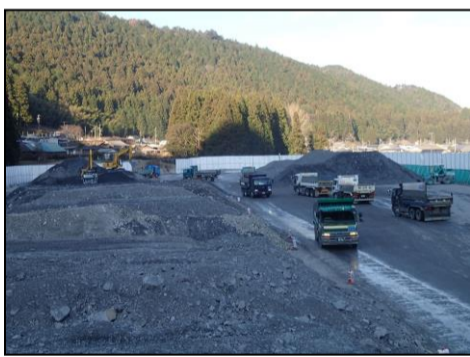
ハツ田仮置場 施工状況
