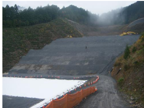
横見地区施工箇所
