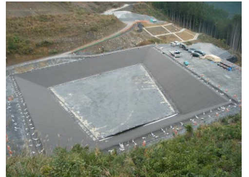
横見地区施工箇所
