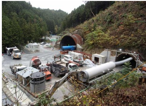
トンネル坑口状況
