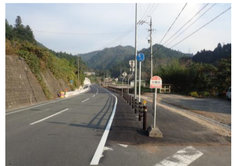
国道151号完了状況
