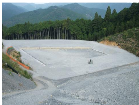
横見地区施工箇所
