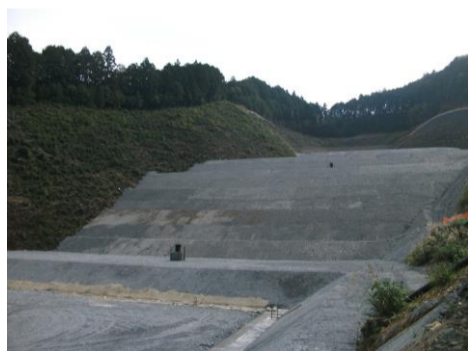
横見地区施工箇所
