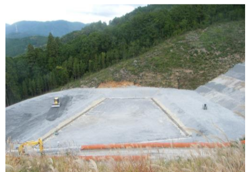
横見地区施工箇所
