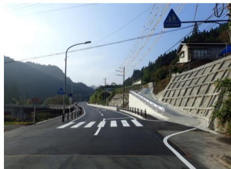
国道151号完了状況
