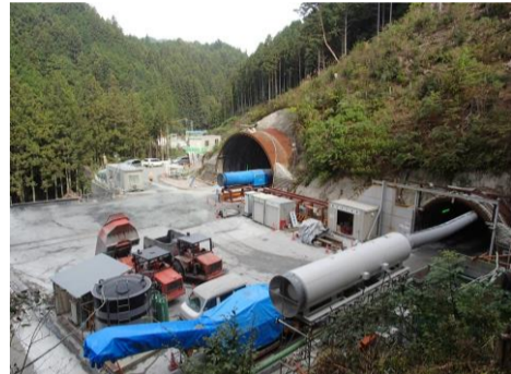
トンネル坑口状況
