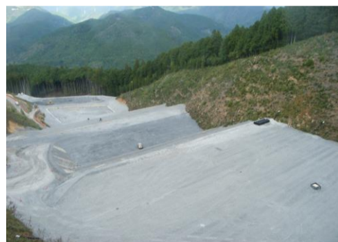
横見地区施工箇所
