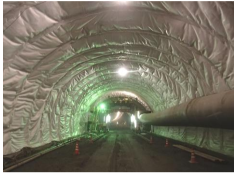
トンネル施工状況(防水シート設置)
