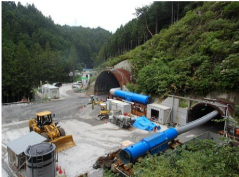
トンネル坑口前状況
