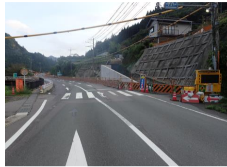
(国道151号)施工状況
