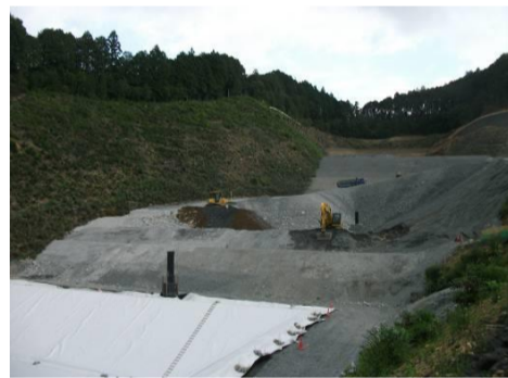
横見地区施工箇所
