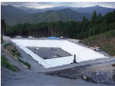
横見地区施工箇所
