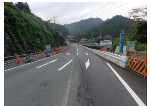
(国道151号)施工状況
