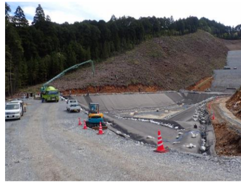
(横見地区)遮水工施工状況
