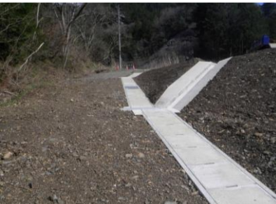
ヨラキ地区 側溝掘付完了
