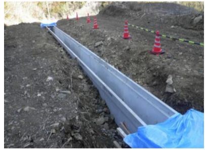
ヨラキ地区 側溝据付箇所
