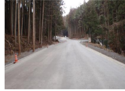
林道拡幅箇所(小田支線)
