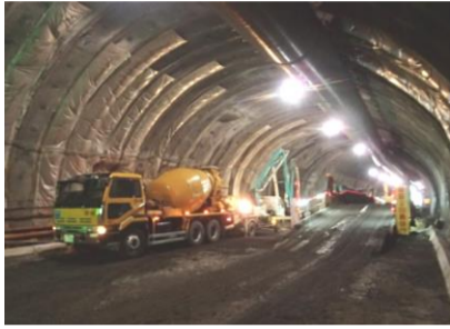
トンネル掘削施工状況
