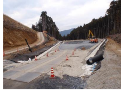
盛土箇所(横見地区)
