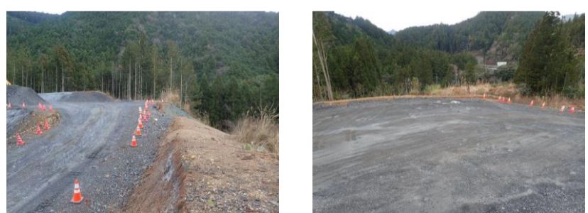
橋台施工箇所 橋台施工箇所
