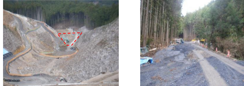
盛土箇所(横見地区) 林道拡幅箇所(小田支線)
