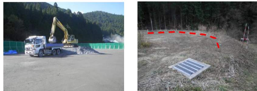
ハツ田地区 運搬状況 ヨラキ地区 側溝据付箇所
