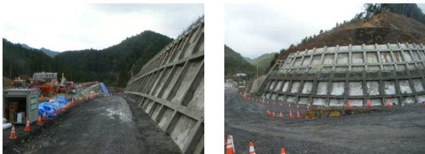
東栄IC部 作業箇所写真
