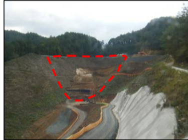
盛土箇所(横見地区)
