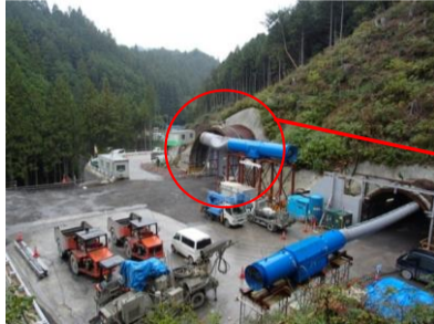
トンネル坑口状況
