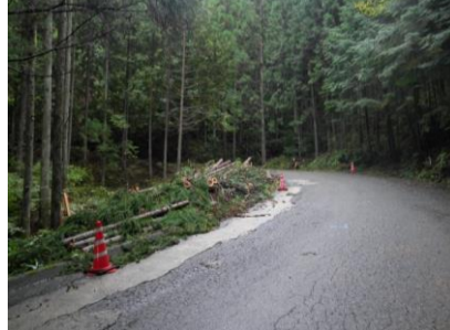
林道補修・待避所(林道小田線)
