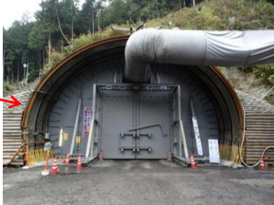
本坑坑口の防音扉
