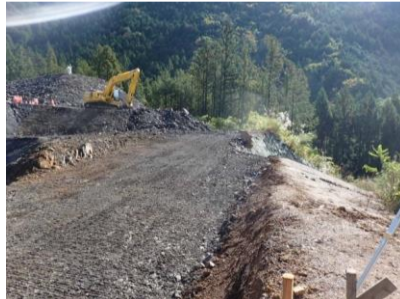
橋台施工箇所
