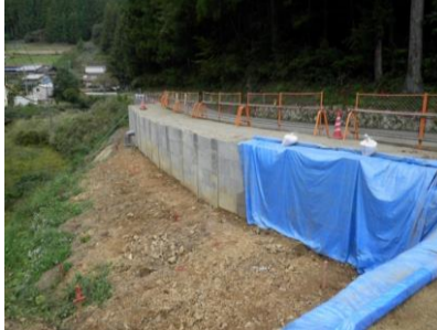
土留・仮橋設置(深谷地区)
