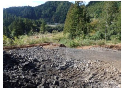
橋台施工箇所
