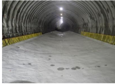
本坑のインバート打設完了
