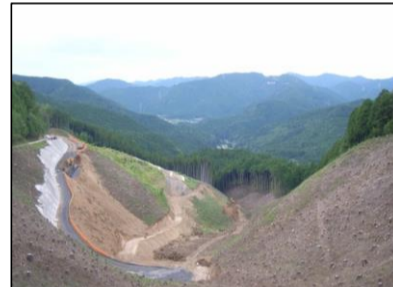
盛土予定地(横見地区)
