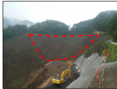
盛土予定地(横見地区)
