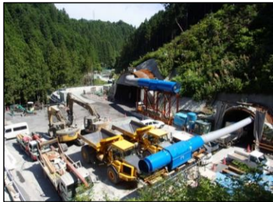
トンネル坑口状況
