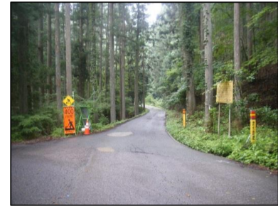
林道幅員予定箇所(小田線支線)
