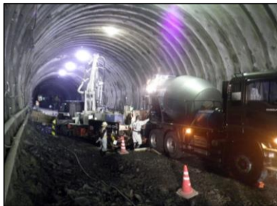
インバート施工状況
