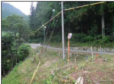
土留・仮橋設置(深谷地区)
