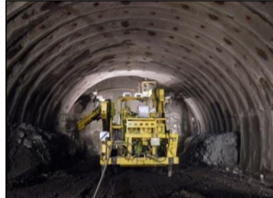
本坑施工状況(鋼製支保工建込み)
