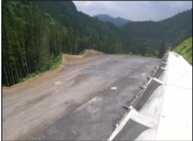
掘削作業箇所写真(東から撮影)
