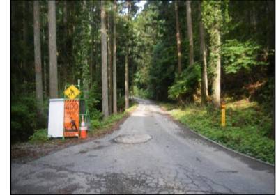
林道拡幅予定箇所(小田線支線)
