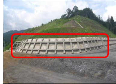
法面施工箇所写真(南から撮影)
