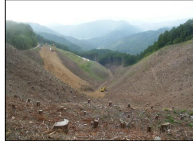
盛土予定地(横見地区)
