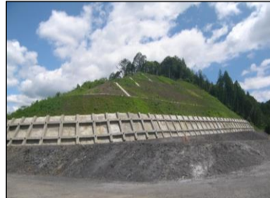
東栄IC部 施工箇所写真
