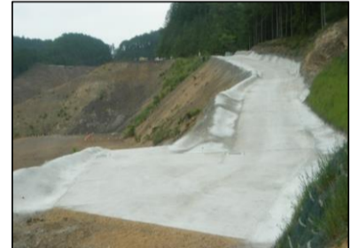
残土受入地(横見) 進入路施工完了
