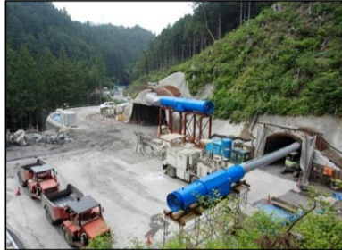
トンネル坑口状況
