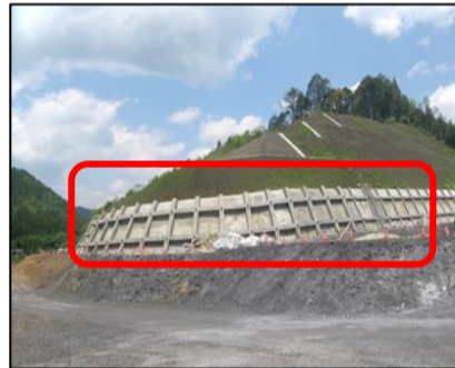
法面施工箇所写真(南から撮影)
