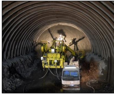
本坑 坑内状況
