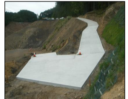
残土受入地(横見進入路施工箇所)
