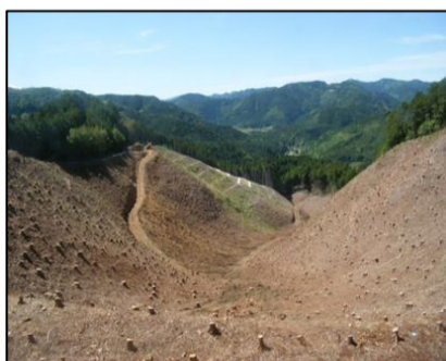
盛土予定地(横見地区)
