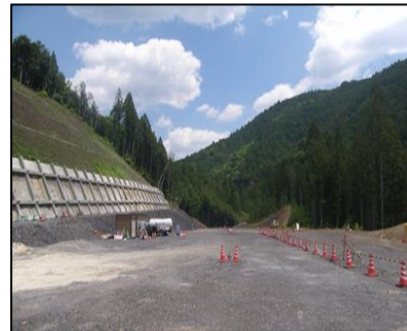
東栄IC部 施工予定箇所写真
