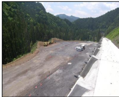
掘削作業箇所写真(東から撮影)
