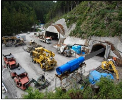
トンネル施工状況
