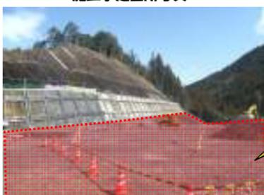
本線及びランフの掘削を行い、掘削箇所の法面保護を行います。
