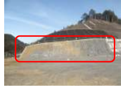
法面施工箇所写真(南から撮影)
