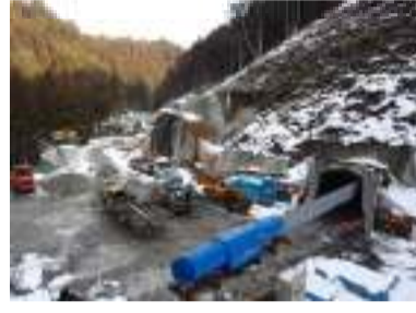
トンネル施工状況
