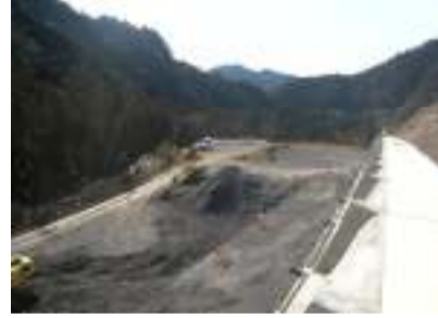
掘削作業箇所写真(東から撮影)
