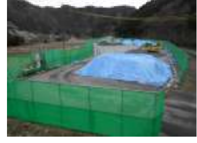
下田スリ仮置場状況
