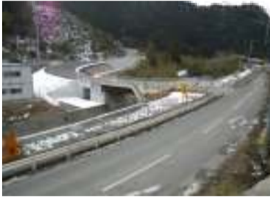
国道より連絡路を望む
