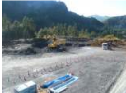
掘削作業箇所(東栄IC本線)
