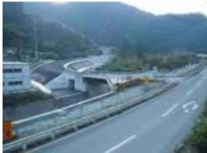
国道より連絡路を望む
