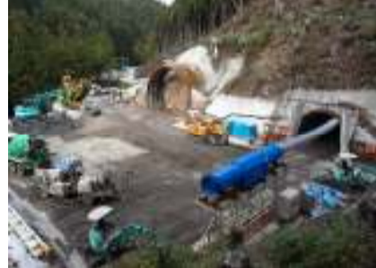
本坑・避難坑 坑口状況
