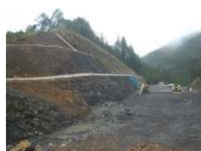
施工予定箇所写真(西から撮影)
