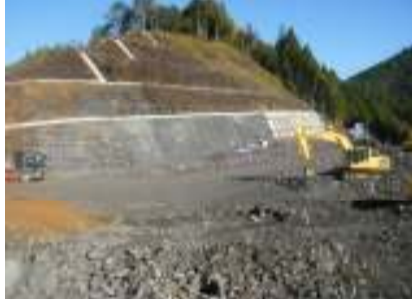
法面施工箇所(東栄IC本線)
