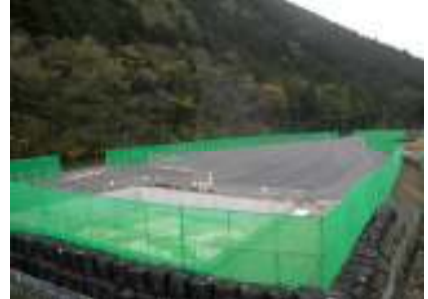
残土仮置場完了
