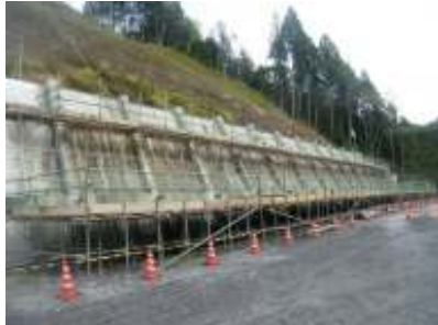
法面施工箇所(東栄IC本線)
