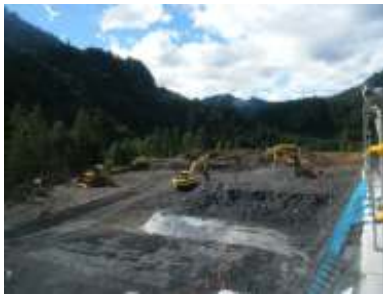
掘削作業箇所(東栄IC本線)
