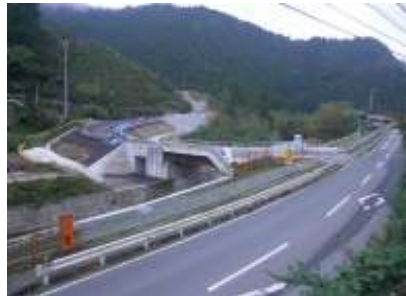
国道より連絡路を望む
