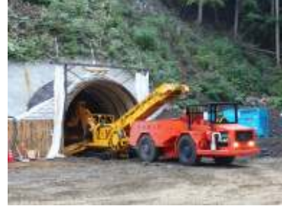
トンネル掘削状況
