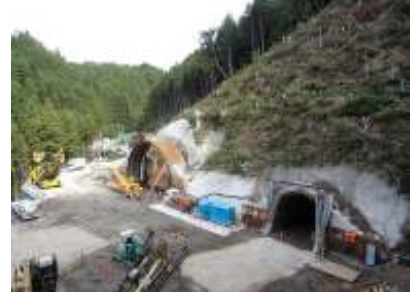
本坑・避難坑 坑口状況
