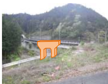
施工予定箇所写真(東から撮影)
