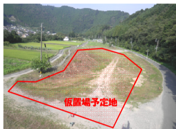
②掘削残土仮置き場施工前状況
