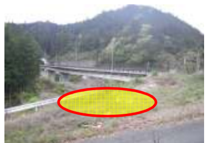
施工予定箇所写真(北から撮影)
