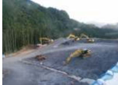
掘削作業箇所(東栄IC本線)
