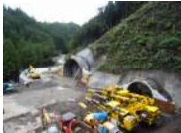
①本坑・避難坑 坑口付け完了
