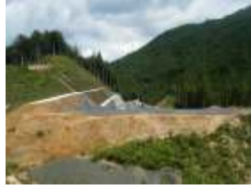
【掘削作業箇所(東栄IC部)】
