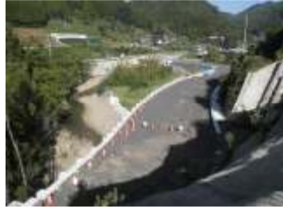
連絡路より国道を望む
