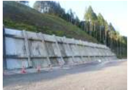
法面施工箇所(東栄IC本線)
