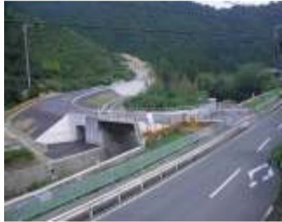
国道より連絡路を望む
