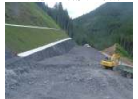
法面施工箇所(東栄IC本線)
