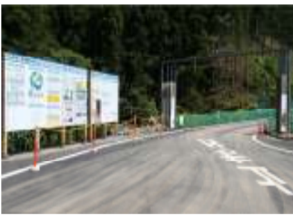
①工事現場入り口
