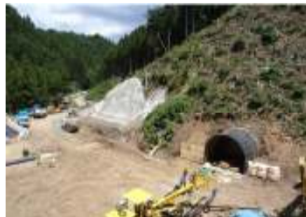
②本坑・避難坑の施工状況
