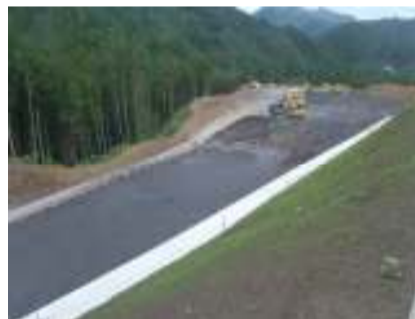
掘削作業箇所(東栄IC本線)
