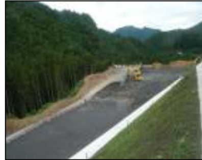
【掘削作業箇所(東栄IC部)】
