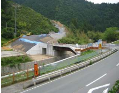
国道より連絡路を望む
