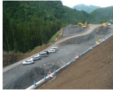
【掘削作業箇所(東栄IC部)】
