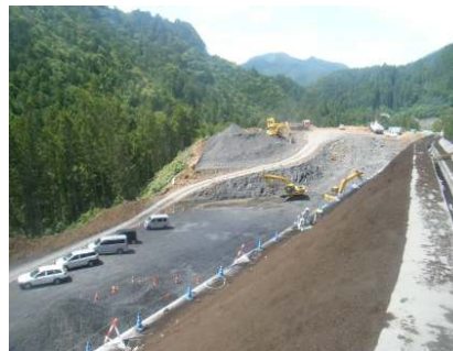
掘削作業箇所(東栄IC本線)
