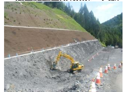
法面施工箇所(東栄IC本線)
