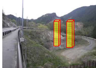
施工予定箇所写真(南から撮影)
