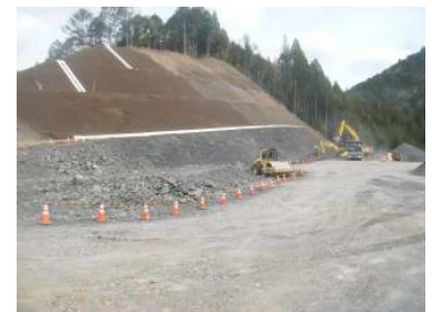
法面施工箇所(東栄IC本線)
