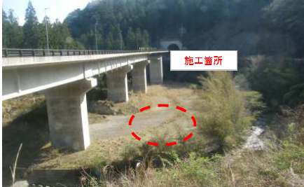
施工箇所を望む
