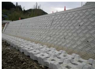
奈根川護岸工事
