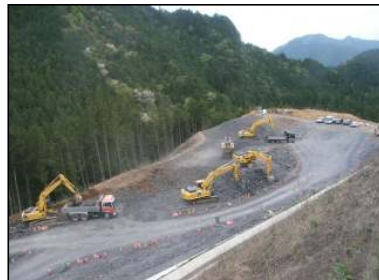
〔掘削作業箇所(東栄IC部)〕
