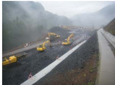
掘削作業箇所(東栄IC本線)
