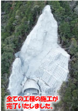
1号トンネル飯田市側 至 浜松
