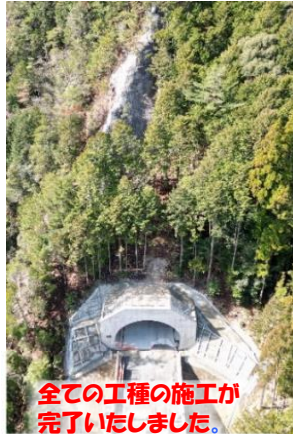
2号トンネル飯田市側 至 浜松
