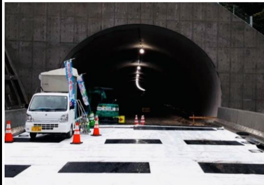
起点側坑口 (浜松市側)
