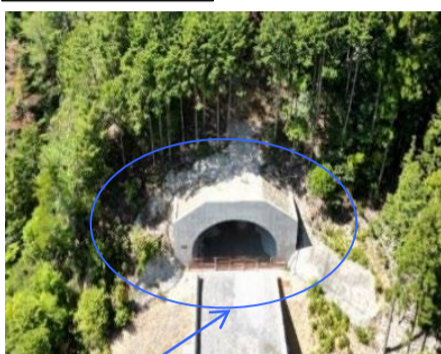
2号トンネル北側
