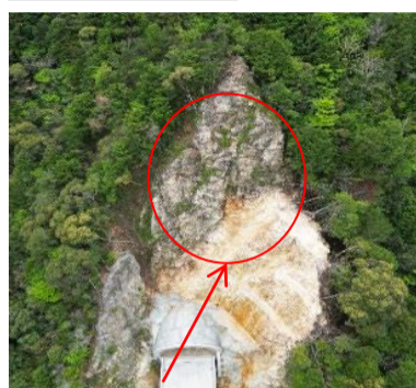
1号トンネル北側
