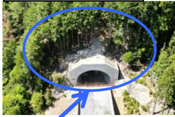
2号トンネル北側
