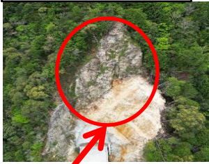
1号トンネル北側
