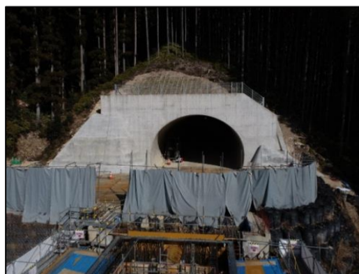
起点側坑門工完了状況
