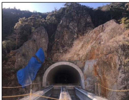
終点側坑門工完了状況
