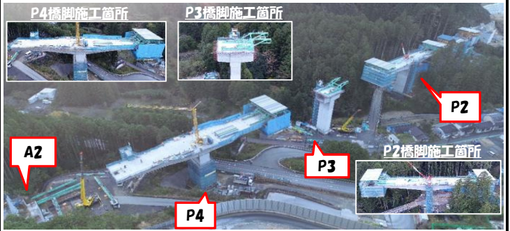
工事箇所全景
