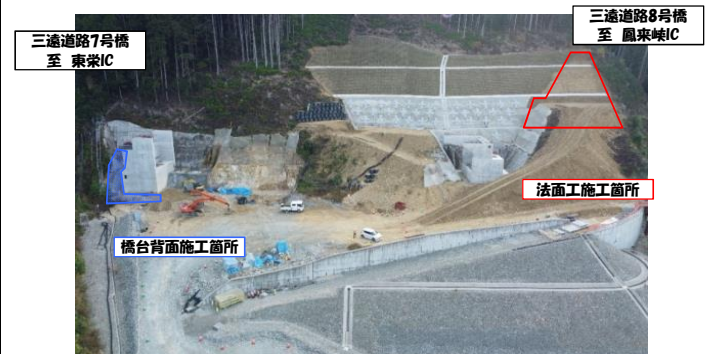
工事箇所全景
