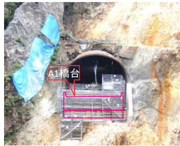
北側坑口状況
