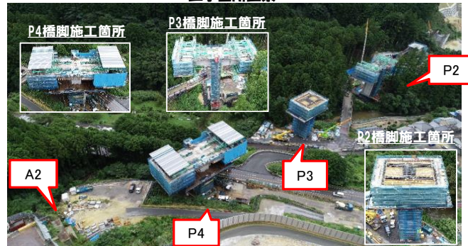
工事箇所全景
