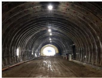
インバート埋戻し状況
