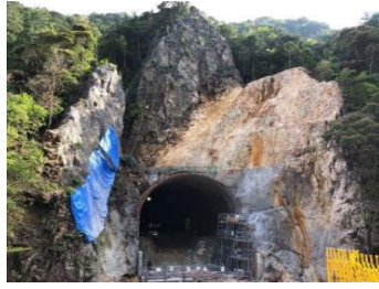
北側坑口状況
