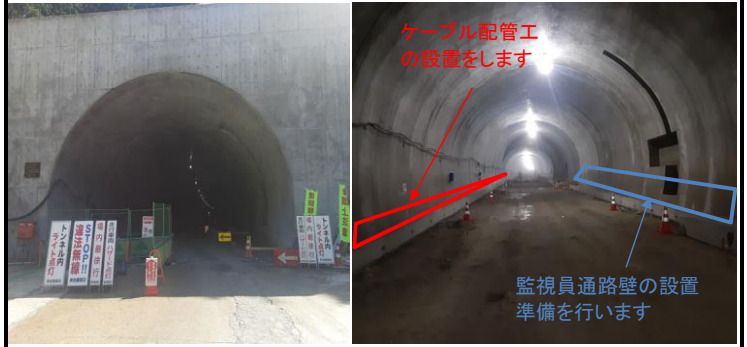
工事箇所全景
