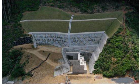
工事箇所全景
