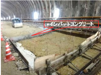
インバート型枠設置状況
