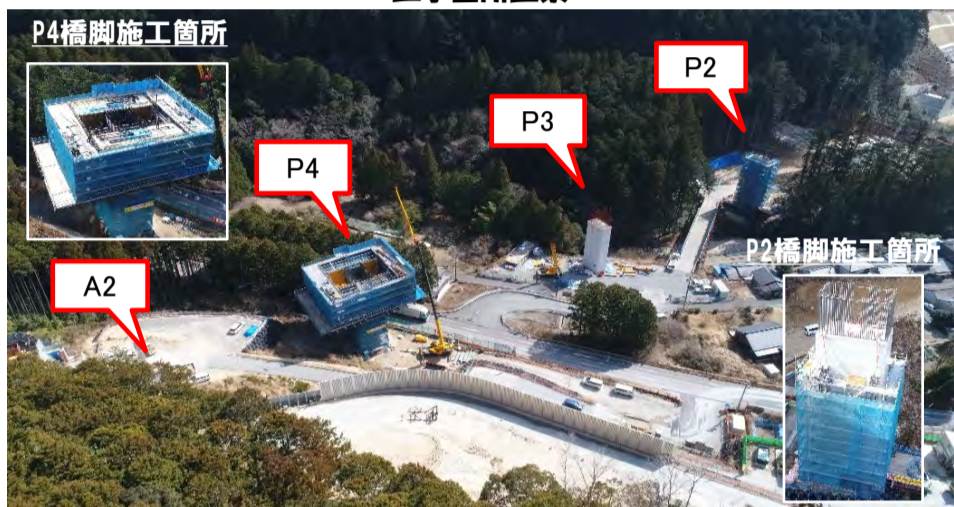
工事箇所全景
