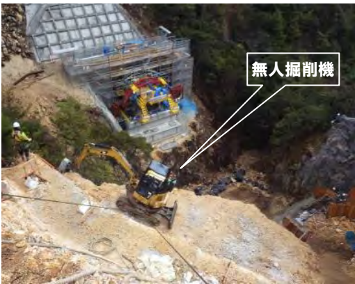
終点側施工状況
