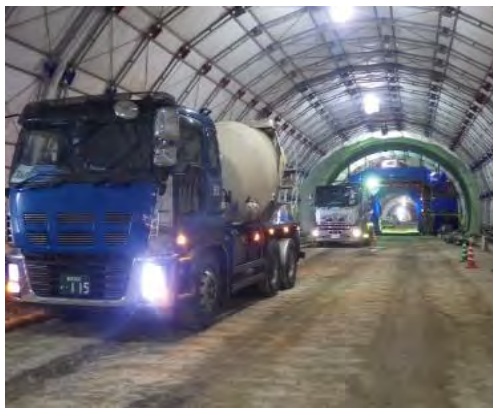
覆工コンクリート施工状況
