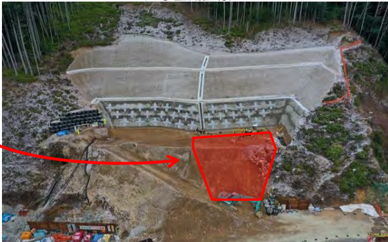
工事箇所全景
