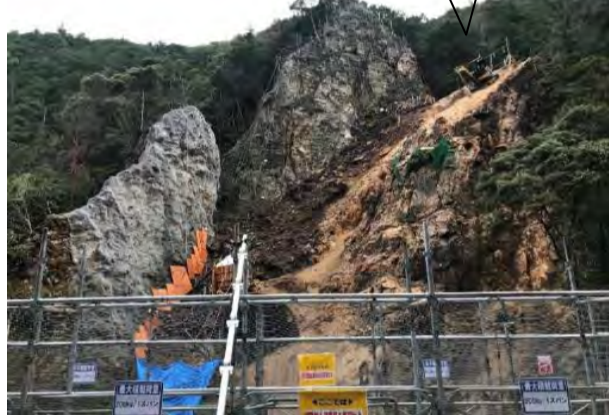
終点側正面施工状況
