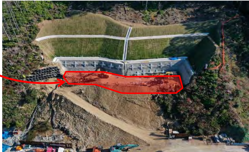
工事箇所全景
