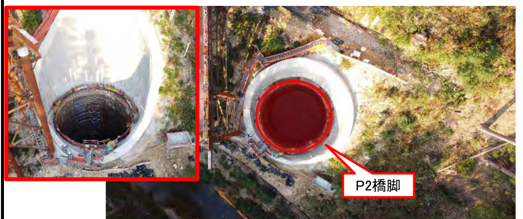
工事箇所全景
