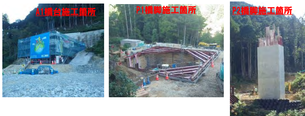
工事箇所全景
