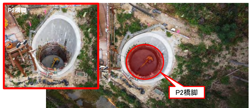
工事箇所全景
