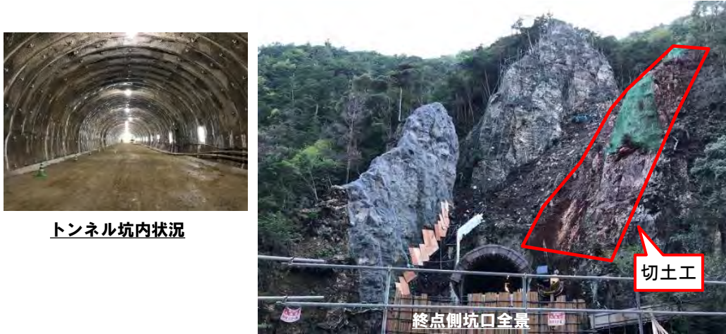
工事箇所全景
