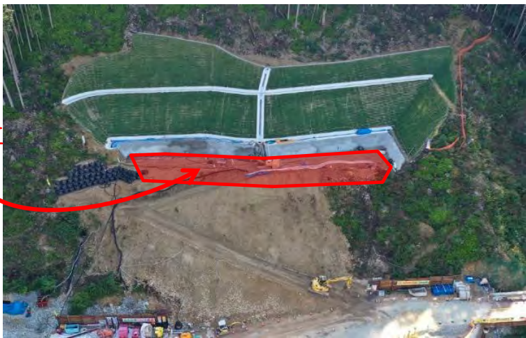
工事箇所全景
