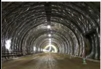
トンネル坑内状況
