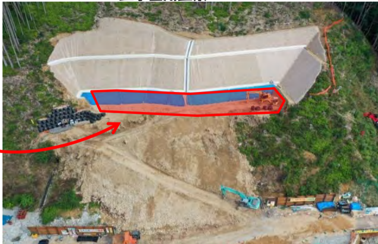
工事箇所全景
