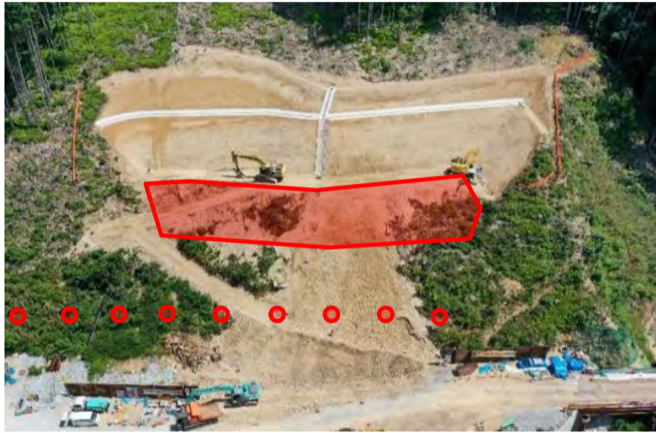
工事箇所全景
