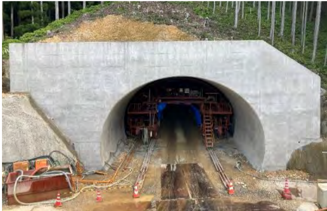
起点側坑門工
