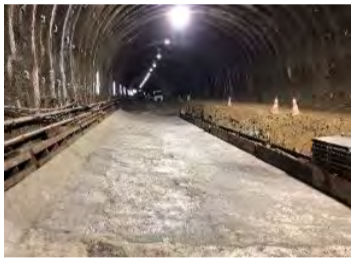
坑内インバート工
